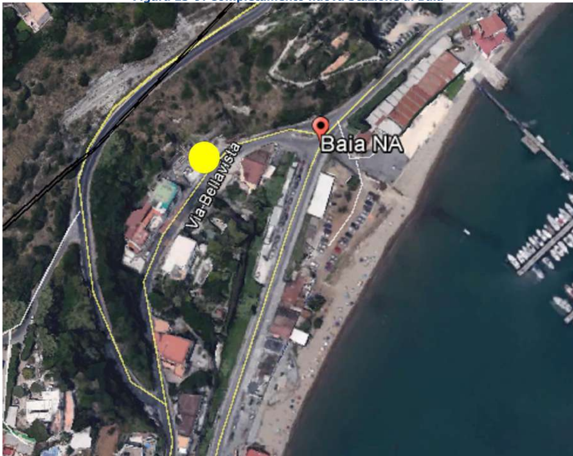
Figura 13-9: Completamento nuova Stazione di Baia
