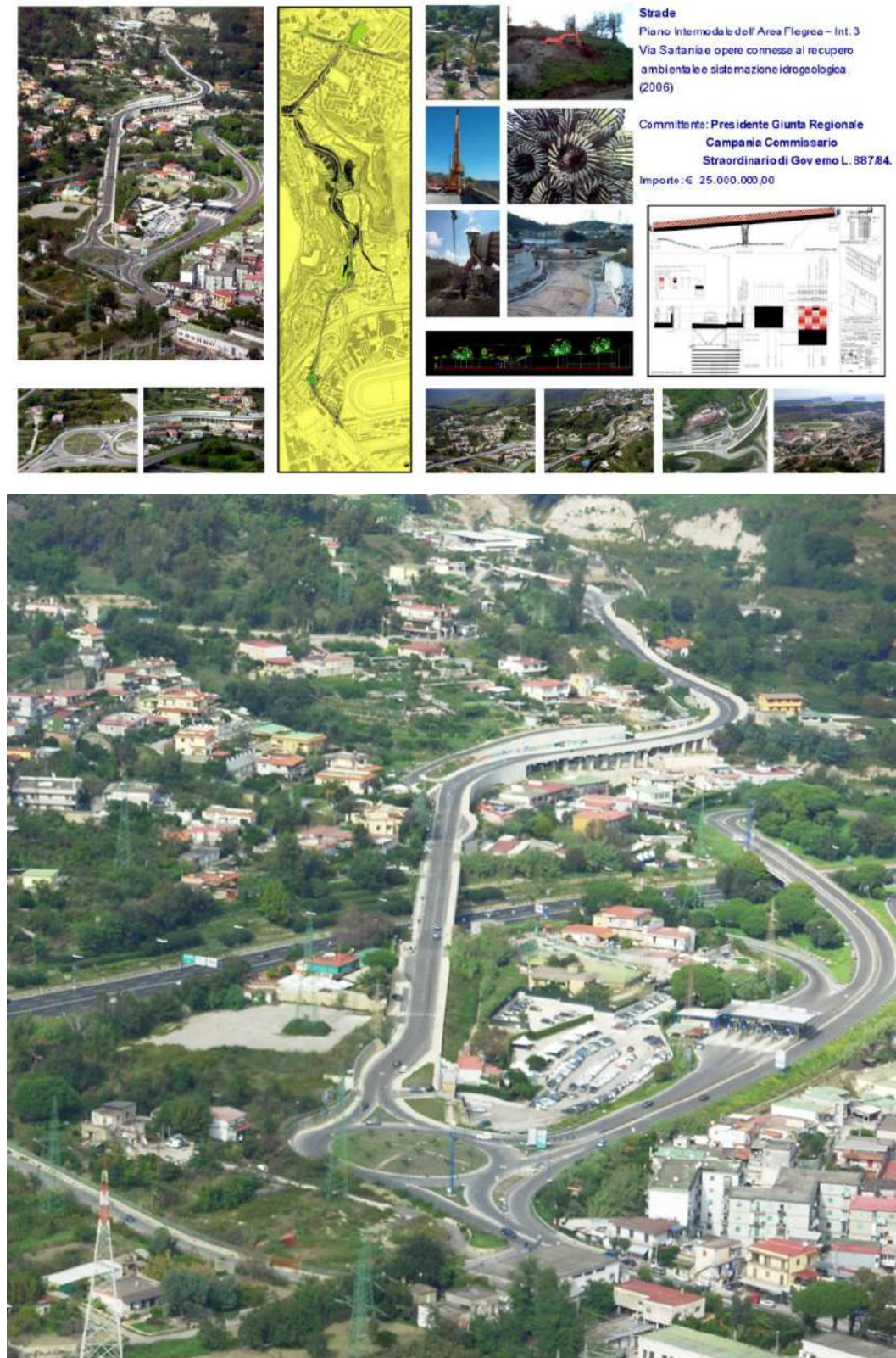
Figura 13-2: Programma di Adeguamento del trasporto intermodale nelle zone interessate dal fenomeno bradisismico (art.11 della Legge 887/84) Piano Viario - intervento 3 Via Sartania - Lotti 1-2-3
