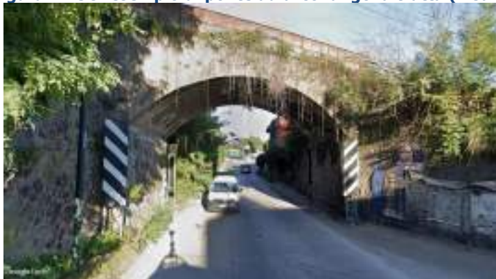
Figura 12-98: esempio di ponte ad arco lungo la tratta (Pisani)
