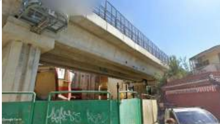
Figura 12-99: esempio di viadotto lungo la tratta (Quarto Centro)
