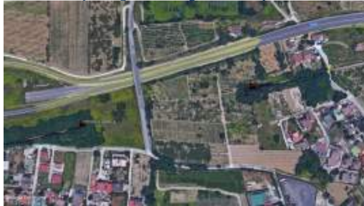
Figura 12-100: esempio di galleria lungo la tratta (Grotta del Sole - Quarto)
