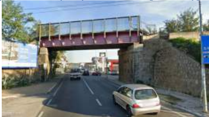
Figura 12-97: esempio di ponte metallico lungo la tratta (Quarto)
