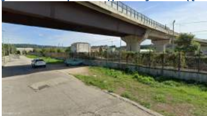
Figura 12-103: esempio di sovrappasso lungo la tratta (Quarto)
