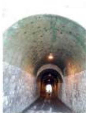
Figura 1.3 - Vista FRP ed intonaco all'interno
