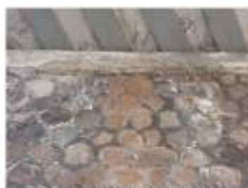
Spalla 2 - Impalcato coperto del pulvino
