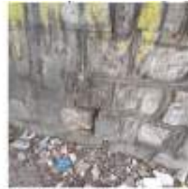
Figura 15 - Detrutturato elemento lapideo ai piedi della pile 7
