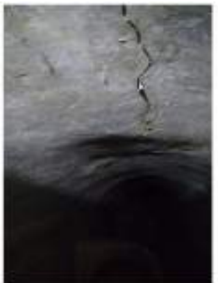
Fessurazioni individuate lungo la volta e le pareti
