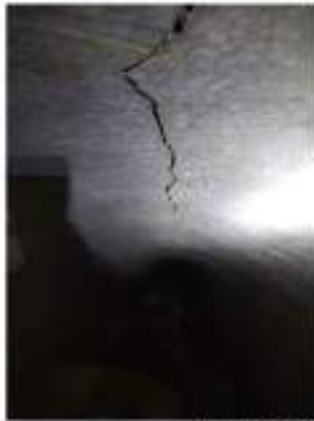
Fessurazioni individuate lungo la volta e le pareti
