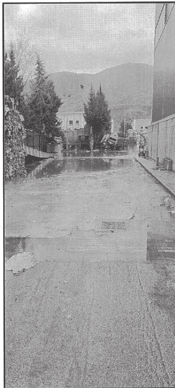
FOTO 4- LATO NORD – SMR01
