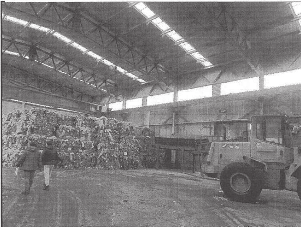
FOTO 20 – INTERNO CAPANNONE VISTA SETTORE MESSA IN RISERVA SMR05
