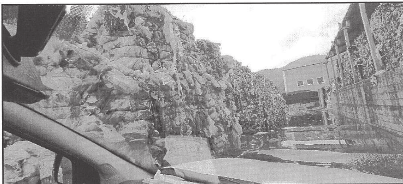
FOTO 9 - A SX SONO POSIZIONATE LE AREE DEPOSITO TEMPORANEO LATO NORD A DX SI INTRADEVE IL MURO DEI BOX COPERTI
