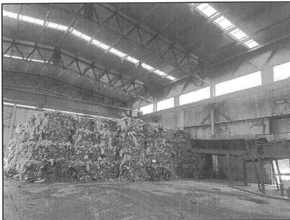
FOTO 21 – INTERNO CAPANNONE VISTA SETTORE MESSA IN RISERVA SMR05
