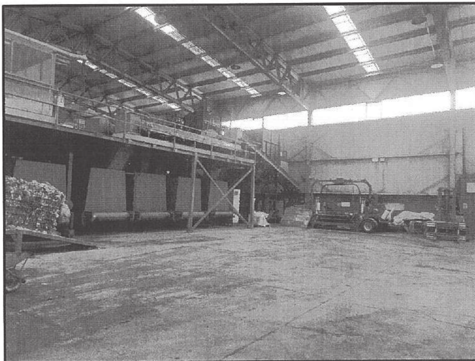
FOTO 18 – INTERNO CAPANNONE VISTA IMPIANTO NON IN FUNZIONE
